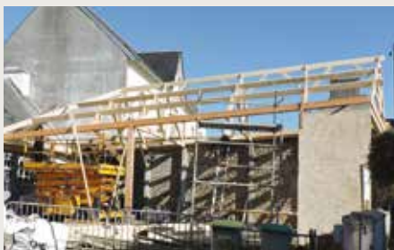
Le chantier avance
